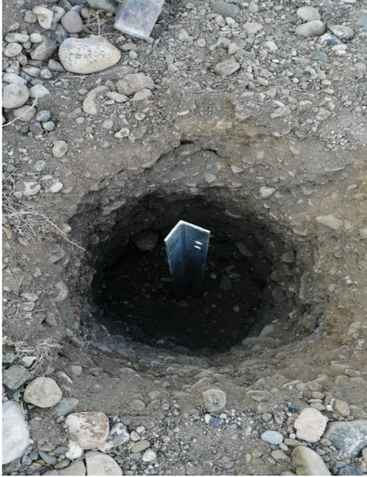
Resim 4.4. Topraklayıcının toprağa yerleştirilmesi
