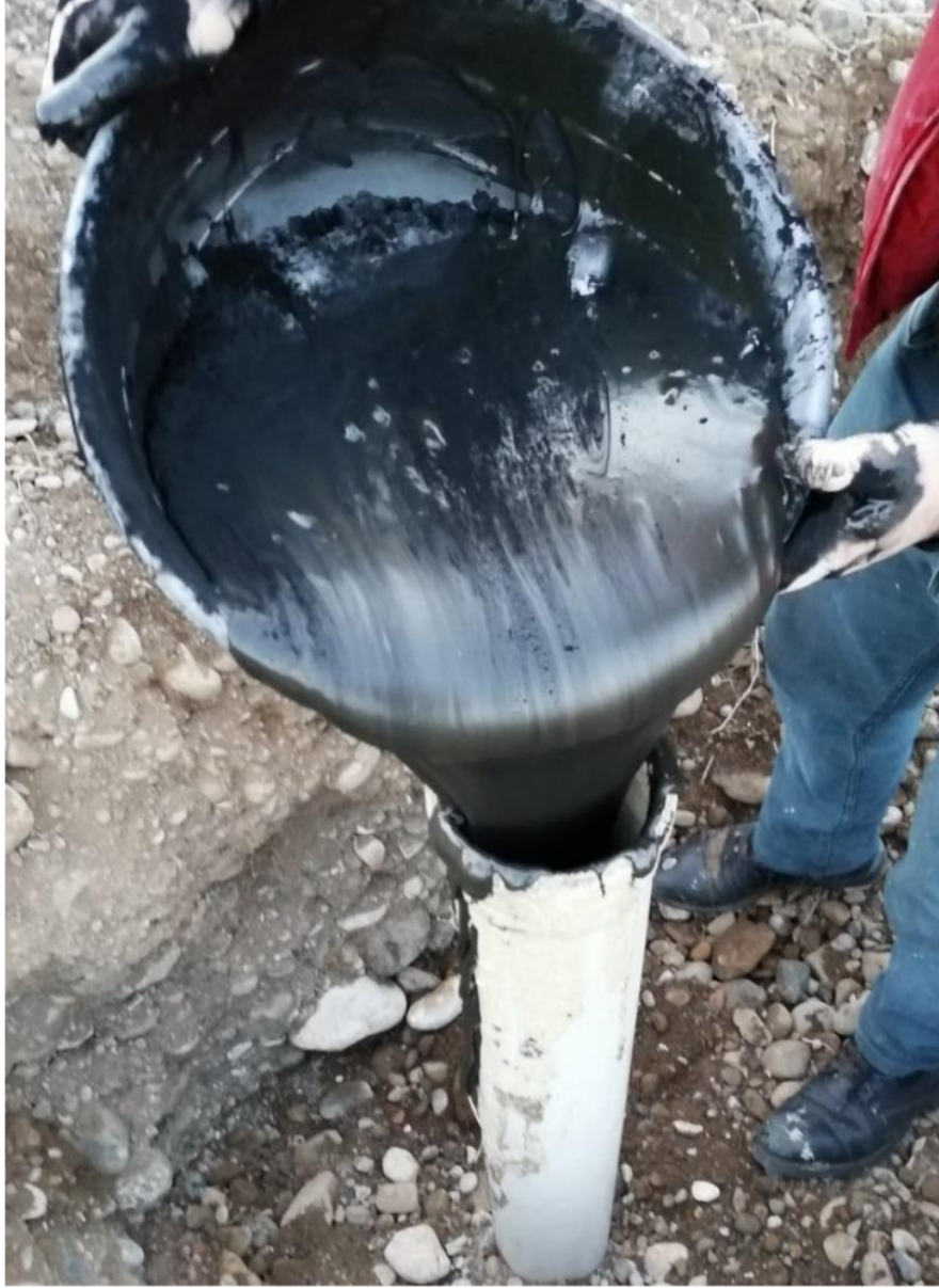
Resim 4.7.Karbon siyahı direnç düşürücünün koyulması
