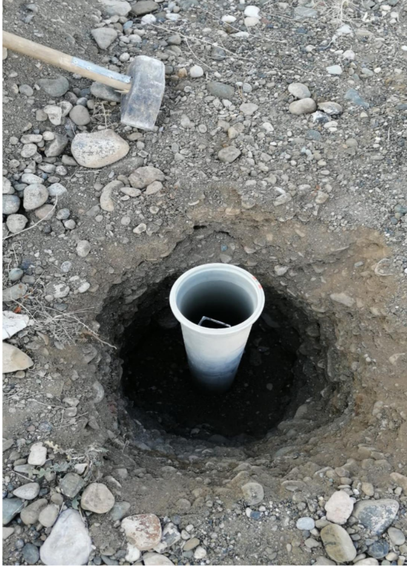
Resim 4.5. Topraklayıcının etrafına direnç düşürücünün kalıbının yerleştirilmesi
